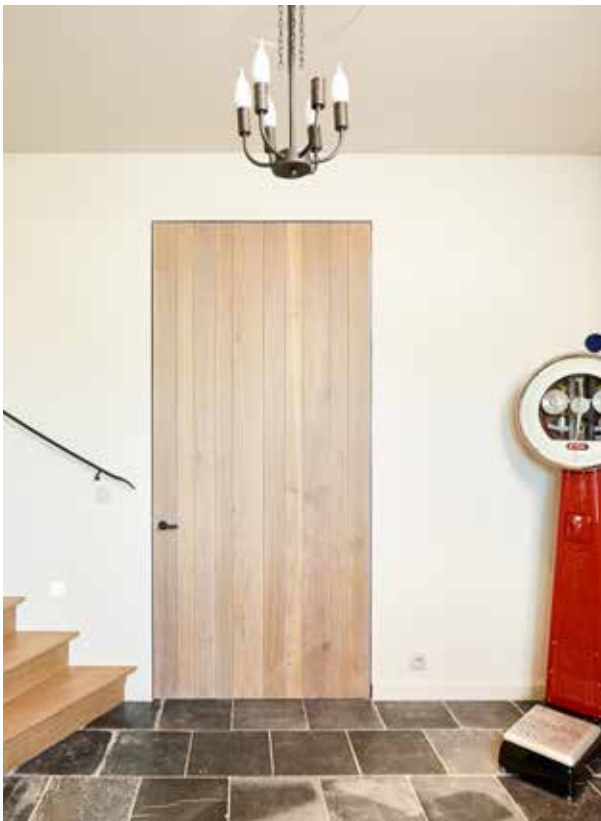
▲ Stalen kassement met onzichtbare scharnieren / Ébrasement en acier avec charnières invisibles
