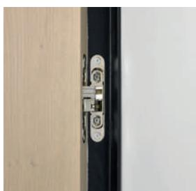
Stalen kassement met onzichtbare scharnieren
