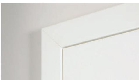
Omlijstingen in verstek, deur en omlijsting in hetzelfde vlak. Dit zorgt voor een strakke uitstraling.
