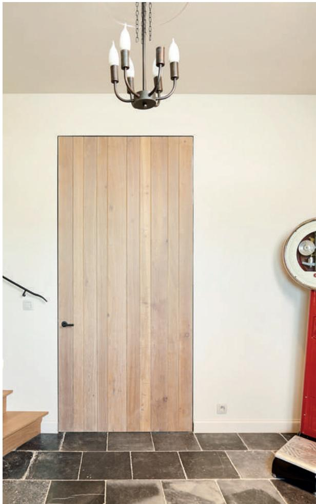
Stalen kassement met onzichtbare scharnieren
